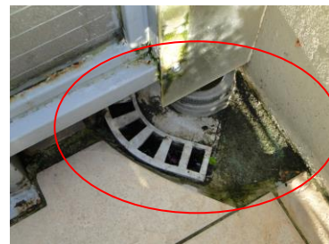
Retirer la grille et nettoyer l'évacuation
